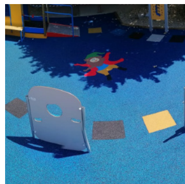
Pavimentazione Colata GSPAVCOL
